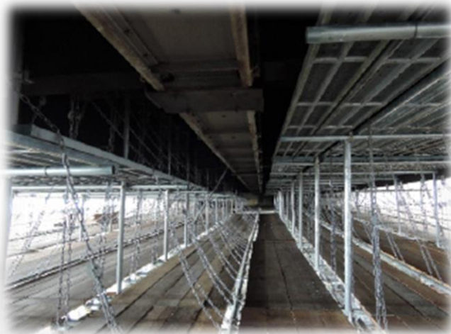
従来の吊り足場
