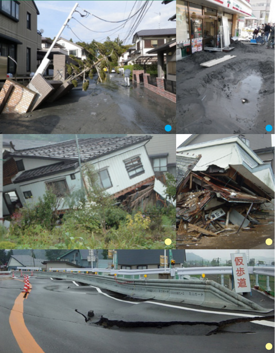
● 2011 年 3 月 11 日 東日本大震災における浦安市の液状化被害 ● 2004 年 10 月 23 日 新潟県中越地震による建物や道路の被害
